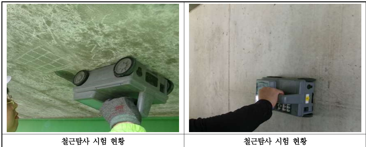
【사진 2.4.2】 철근탐사 시험
