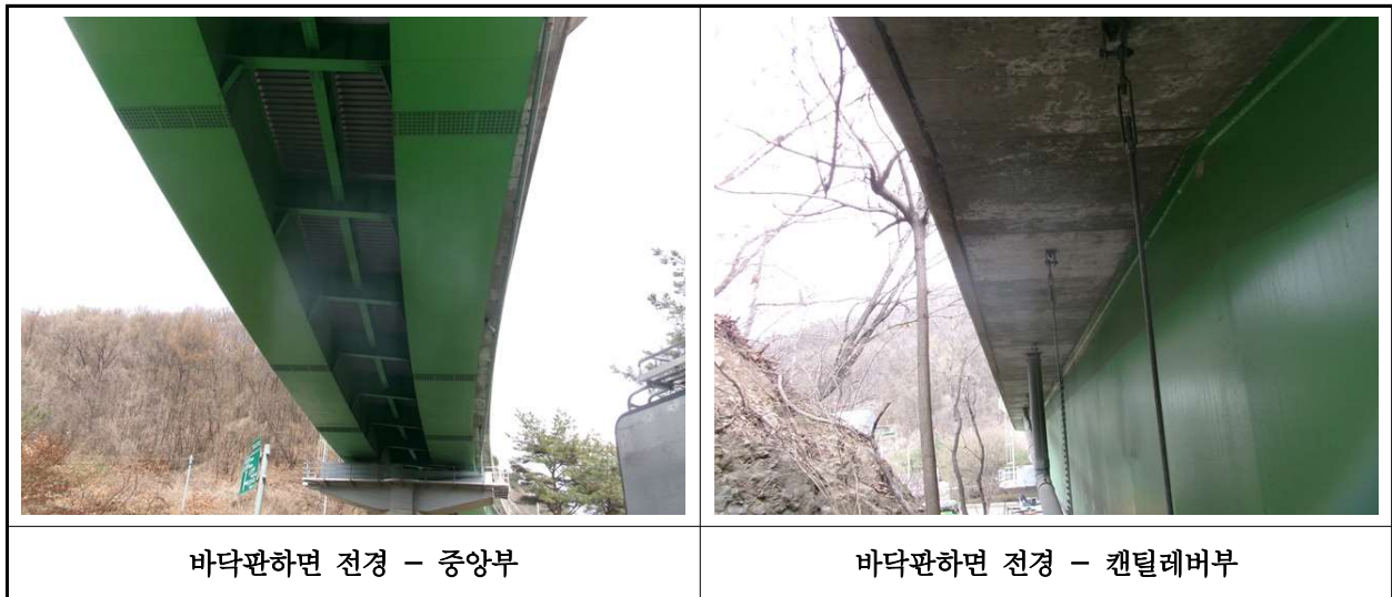
【사진 2.3.2】 바닥판하면 전경
