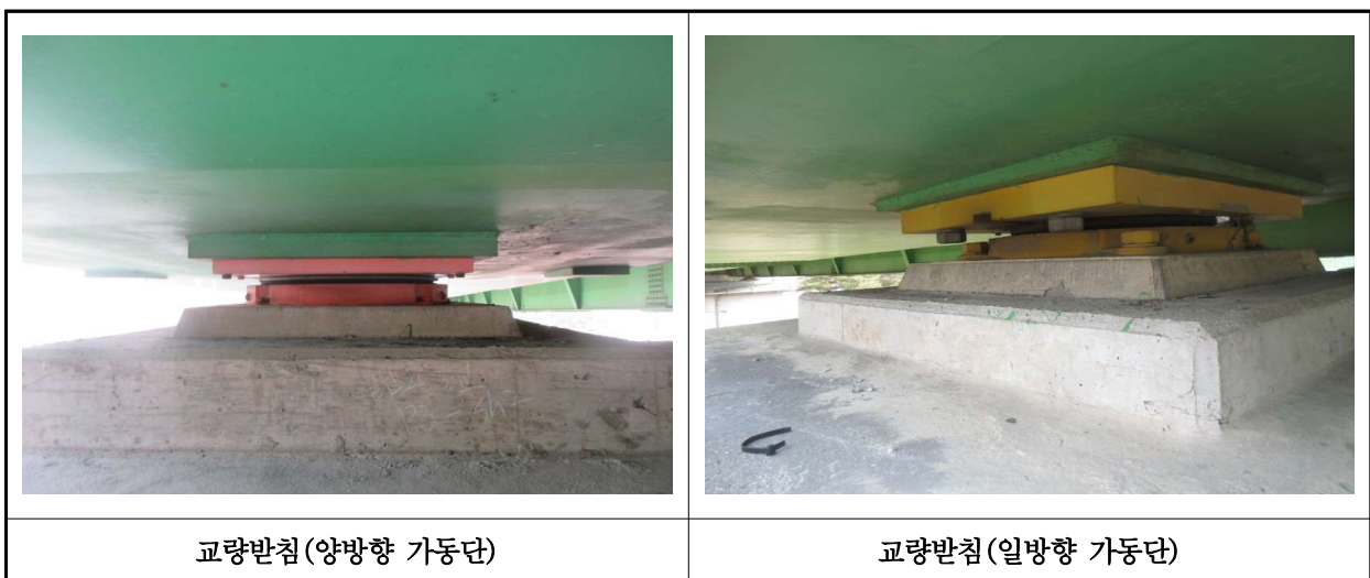
【사진 2.3.13】 교량받침 전경
