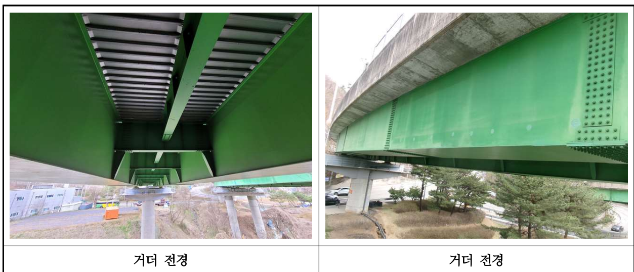
【사진 2.3.4】 거더 전경
