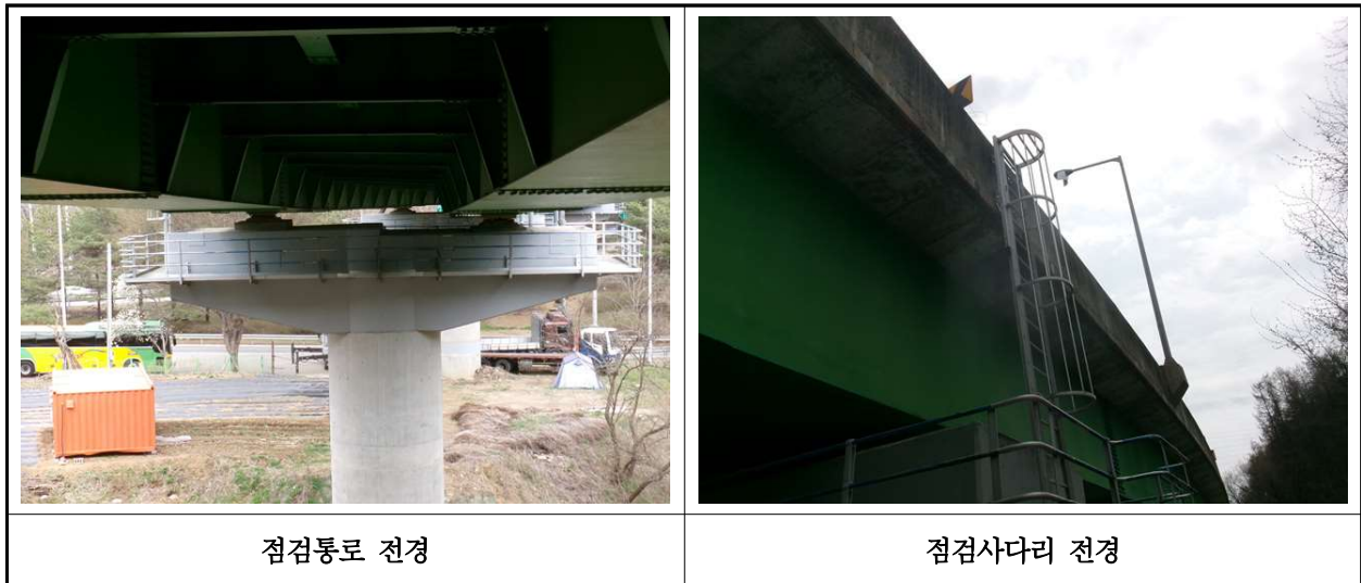
【사진 2.3.23】 교량 점검시설 전경
