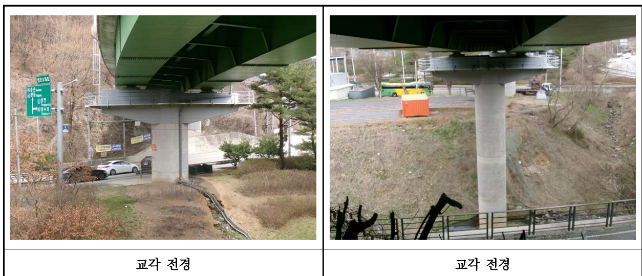
【사진 2.3.11】 교각 전경
