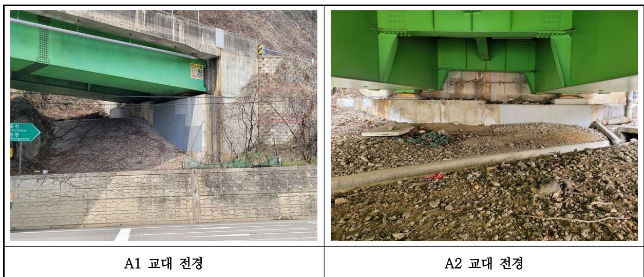
【사진 2.3.9】 교대 전경
