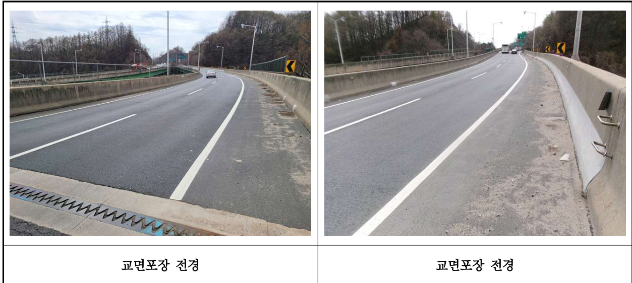
【사진 2.3.17】 교면포장 전경
